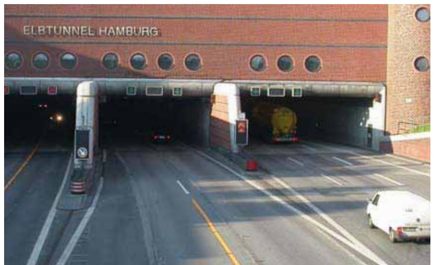
Elbtunnel Röhre 1, 2 und 3, Hamburg
