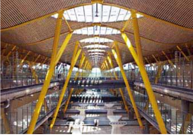
Barajas International Airport, Madrid Architekten: Rogers Stirk Harbour + Partners, Estudio Lamela Lindner übernahm die gesamte Entwicklung und Produktion sowie die Lieferung der nichtbrennbaren Bambusdecke.
